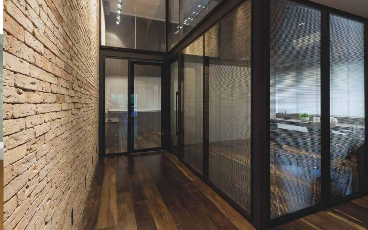
A estrutura é robusta, composta por perfis de alumínio anodizado ou com pintura eletrostática. Na montagem dos módulos, os encaixes nas travessas são feitos com grapas de fixação em nylon e juntas de PVC entre os painéis para isolamento acústico.
